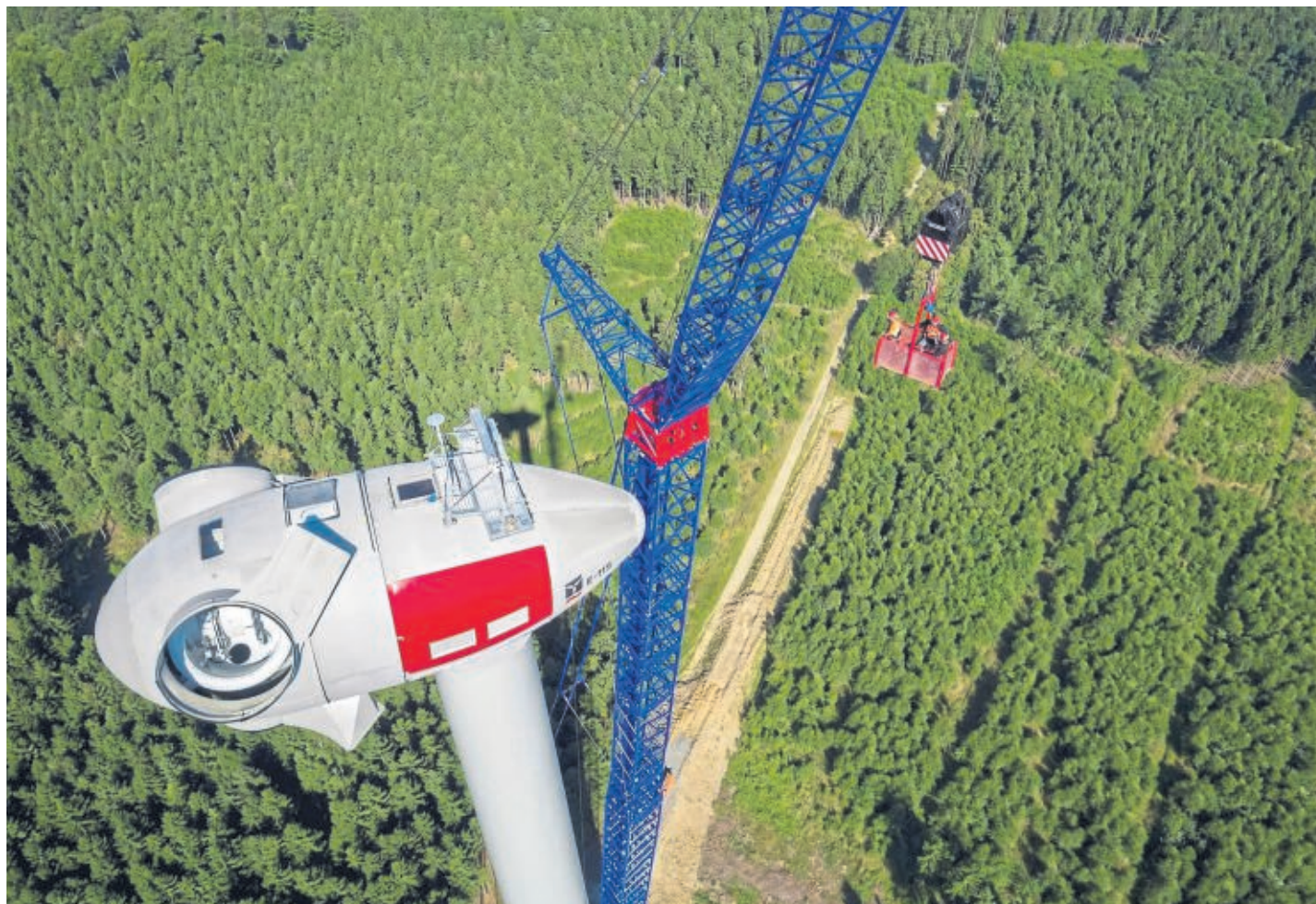
Seit Juli 2017 ist die Niestetaler Energiegenossenschaft DEiN am Windpark Stiftswald mit vier Prozent beteiligt. Das Foto zeigt eines der insgesamt neun Windräder des Windparks während der Bauphase im August 2016.
